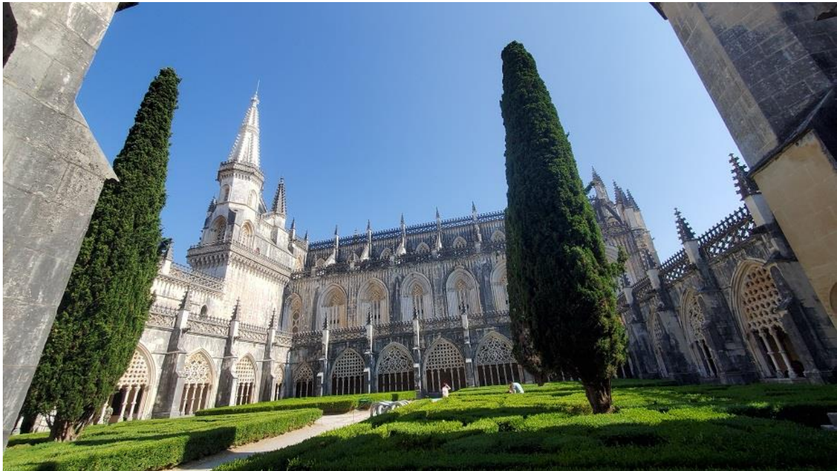
Abbildung 50: Mosteiro da Batalha
